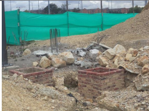
Foto No 5. Espacio público del costado norte donde se termina la pasarela de abordaje: Cajas de inspección de redes secas, sin terminar. Se observa el acero de refuerzo de los pilotes de la estructura de la cubierta tipo Ferrari. La obra presenta un estado de desaseo, desorden y abandono. Se encuentran materiales granulares apilados en diferentes partes.
