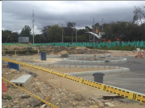
Foto 3. Parqueadero de livianos: conformación del espacio público con bordillos de concreto. Esta vía se encuentra a nivel de asfalto dentro del parqueadero. Actualmente se están tapando las redes secas y se construyen los andenes en concreto.
