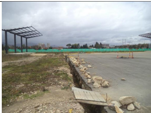
Foto No 5. Espacio público del costado norte donde se termina la pasarela de abordaje: Cajas de inspección de redes secas, sin terminar. Se observa el acero de refuerzo de los pilotes de la estructura de la cubierta tipo Ferrari. La obra presenta un estado de desaseo, desorden y abandono. Se encuentran materiales granulares apilados en diferentes partes.
