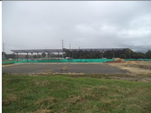
Foto 4. Plataforma de Buses intermunicipales y patio de maniobras: actualmente no se está trabajando en este sector porque no se cuenta con el diseño del pavimento rígido (losas de concreto), diseño que está a cargo del Contratista Estructuras Especiales S.A.
