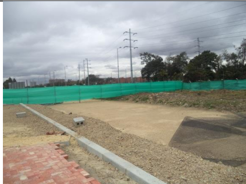
Foto 6. Carril de servicio: el cual no se puede intervenir hasta tanto no se defina por parte del contratista e interventor el empalme de la vía 193 con la autopista norte. Actualmente se encuentra a nivel de base. La polisombra delimita el área de intervención del espacio público a ejecutar por el IDU y el Contratista Estructuras Especiales S.A.
